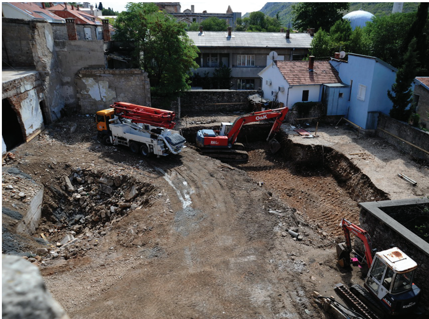
Iskop temelja za proširenje objekta
