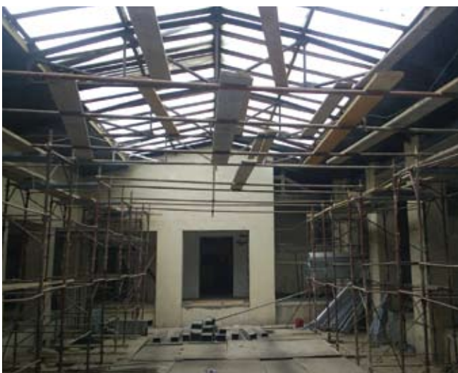
Renoviran je svjetlarnik iznad glavnog hola
