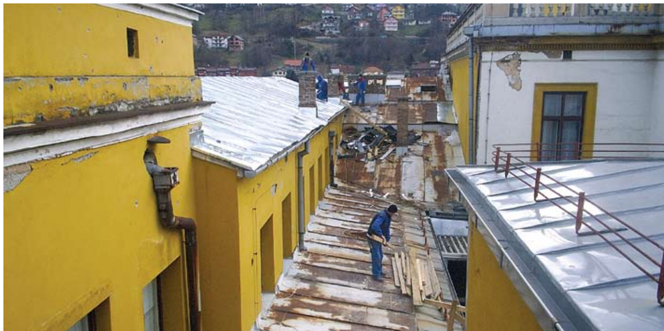
Morao se zamijeniti veliki dio krovne konstrukcije, te većina limenih ploča
