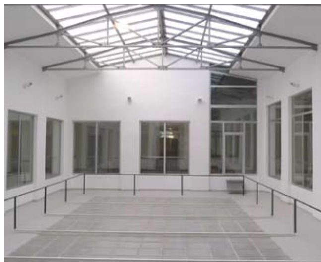
Renoviran je svjetlarnik iznad glavnog hola
