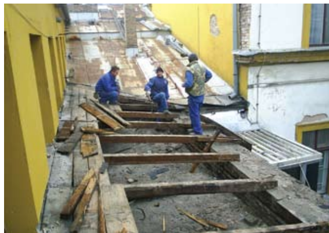
Morao se zamijeniti veliki dio krovne konstrukcije, te većina limenih ploča
