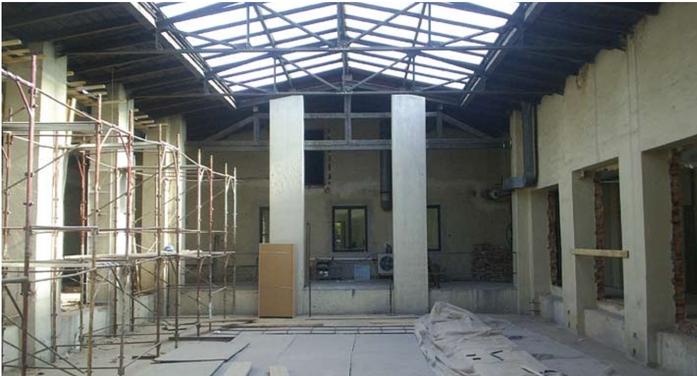
Renoviran je svjetlarnik iznad glavnog hola
