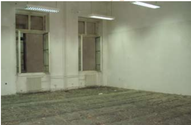
Stari podovi su uklonjeni kako bi se ispod novih podova postavila IT infrastruktura i električne instalacije
